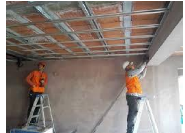
REPARACION DE FALSO CIELO RASO
