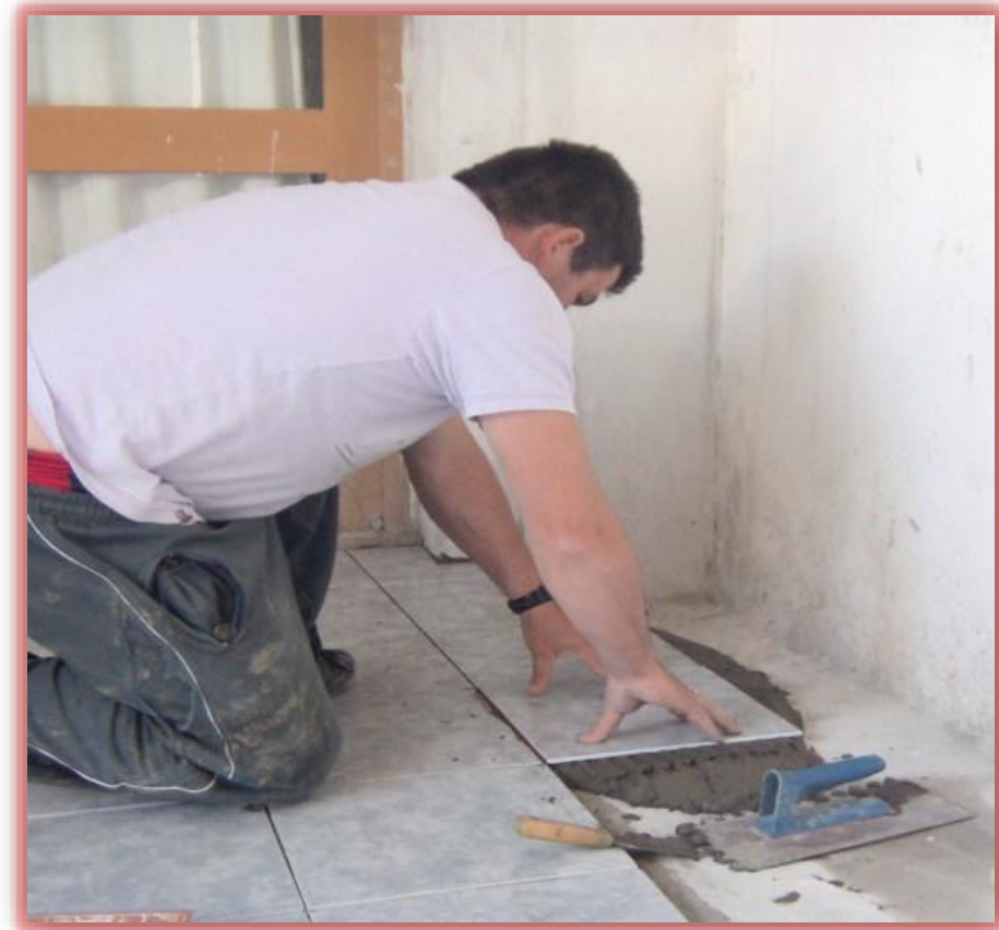
INSTALACIÓN Y/O REPOSICIÓN DE PISO CERÁMICO
