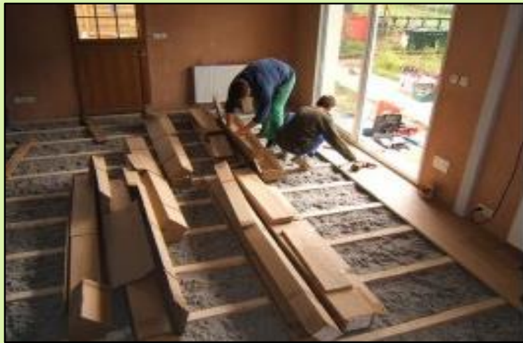
REPOSICIÓN DE ENTABLADO EN PISO DE MADERA (SIERRA / ZONA RURAL)
