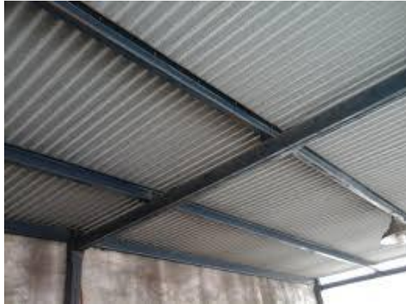
REPARACION Y ARREGLO DE COBERTURAS LIVIANAS
