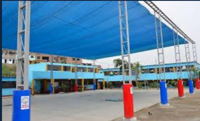
REEMPLAZO Y MANTENIMIENTO DE MALLA POLISOMBRA EXISTENTE Y ELEMENTOS DE SUJECION
