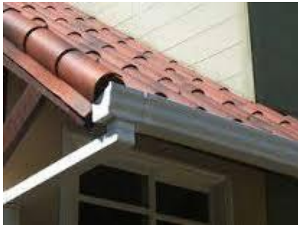
REPARACION DE CANALETAS
