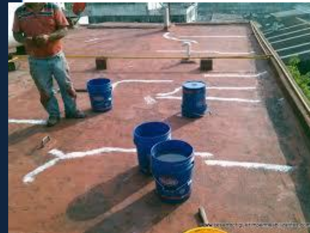
SELLADO DE PERFORACIONES E IMPERMEABILIZACIONES
