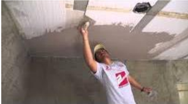
TARRAJEO, ENLUCIDO DEL CIELO RASO EN LOSA ALIGERADA
