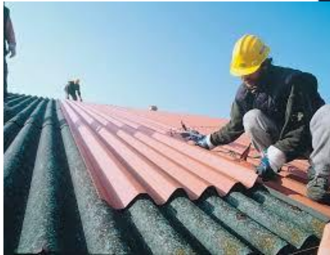
REPARACION Y ARREGLO DE COBERTURAS LIVIANAS
