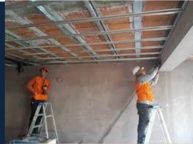
REPARACION DE FALSO CIELO RASO
